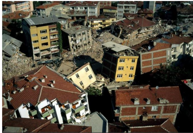
Şekil 2.1 Marmara Depremindeki Çarpışma Hasarları [10].
